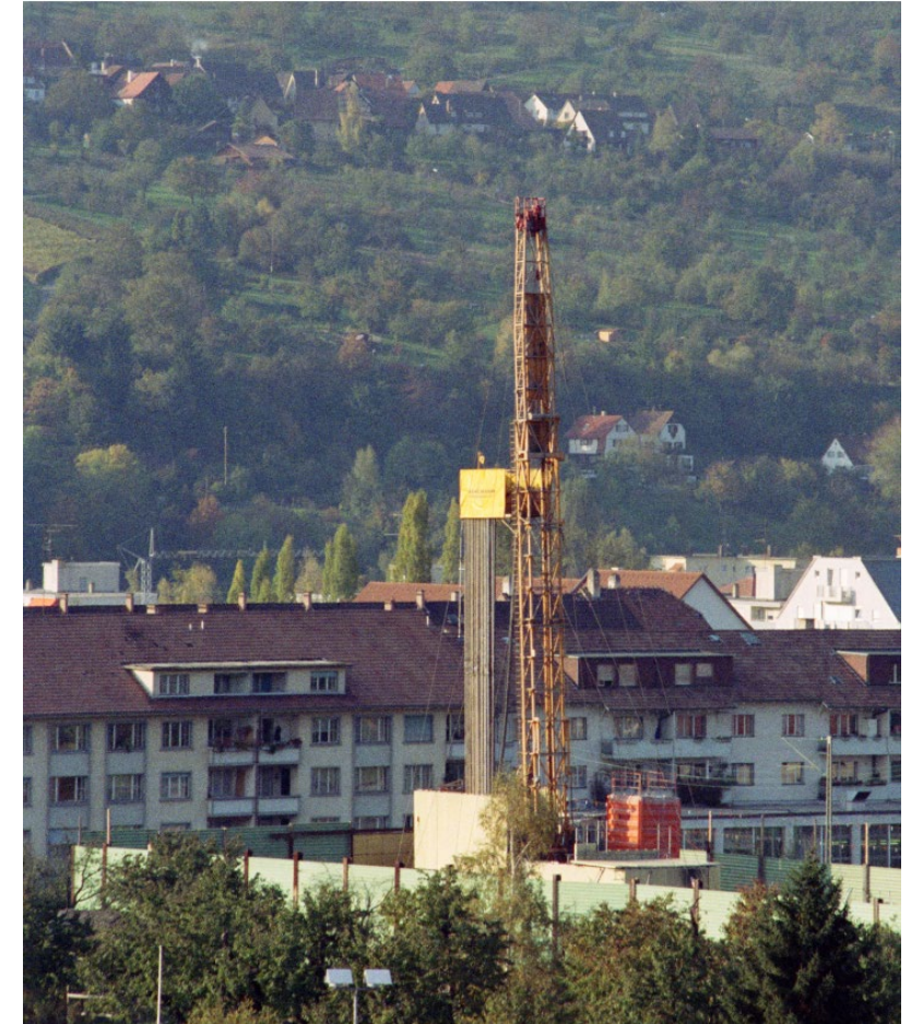
Bohrturm und Bautafel der Bohrungen 1988/89
