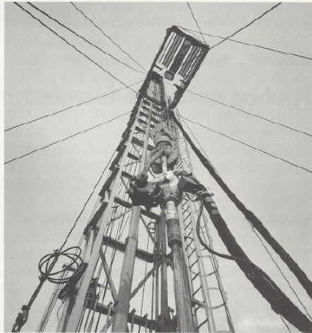
Detailaufnahme Bohrturm mit Bohrgestänge. ◀
